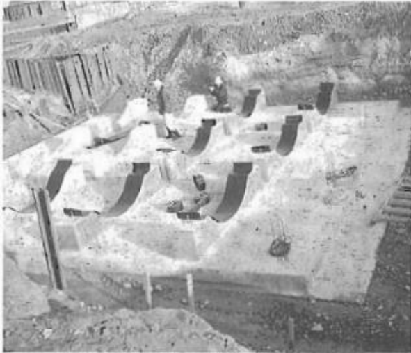
Vi dụ về lắp bể trên gôỉ bê tông
