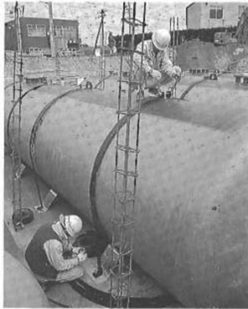
Lắp đặt bể
